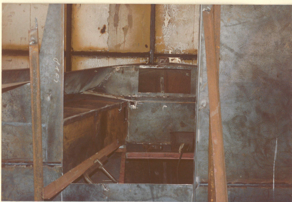
de wals en ventilatie gatm aangebracht
