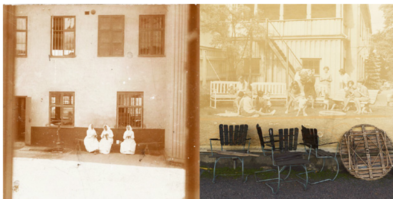
— Bild 5. Diptyk. Det är galler för fönstren . Pågående arbete. b5 —
