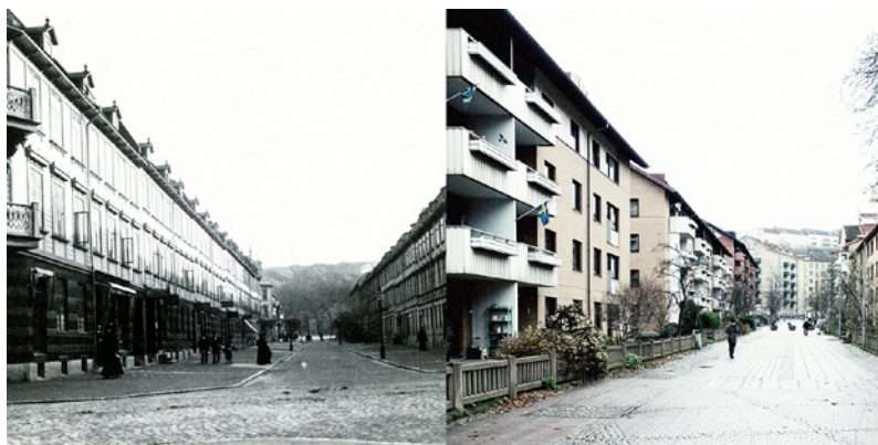
— Bild 3. Diptyk. Borgaregatan, korsningen Olskrokskatan . Pågående arbete. b3 —
